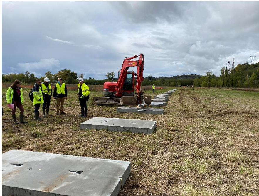
Premières longrines posées mi-octobre 2020
